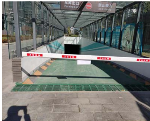
地下车库入口截水沟
